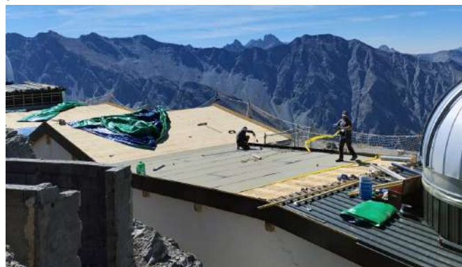
Travaux réalisés par l'entreprise Dautremer de Gap
