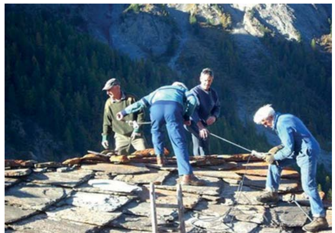
Travaux à la Chapelle Sainte-Elisabeth
