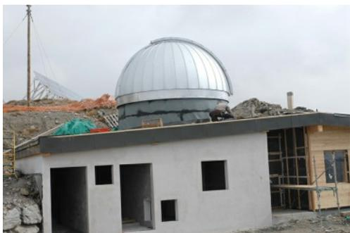
Début octobre, c'est aux équipes de second œuvre d'intervenir. Sont menés de conserve les chantiers de montage des cloisons et isolation, électricité, plomberie. L'aspect extérieur n'évoluera plus beaucoup. Il restera une petite phase de nettoyage de chantier à assurer par AstroQueyras. Par contre, l'intérieur prend vraiment corps avec la pose des cloisons. Les volumes se dessinent maintenant sans ambiguïté. La pose des fermetures extérieures est terminée.
